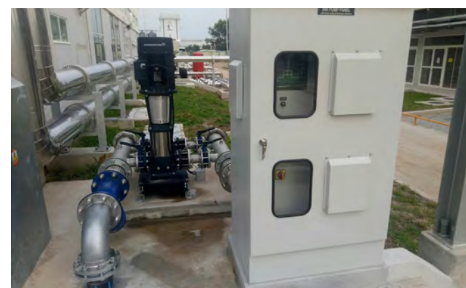
Thiết kế, cung cấp và lắp đặt hệ thống nước thải và thoát nước
