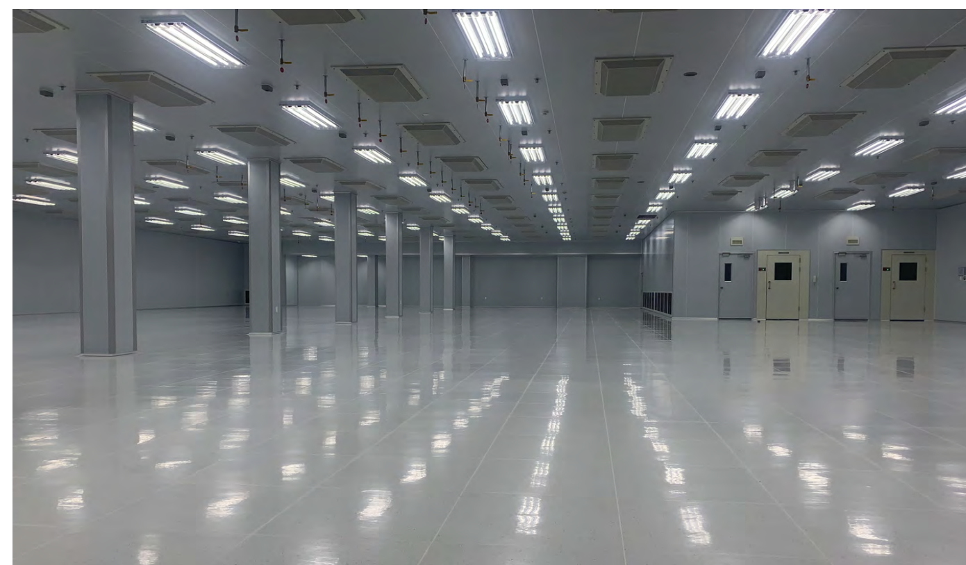
Thiết kế, cung cấp và lắp đặt hệ thống phòng sạch các cấp độ
